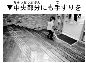
▼中央部分にも手すりを 直前にいきなり点字ブロック が出てくる ので、階段 までの誘導 ブロックが 必要だと思 いました。
